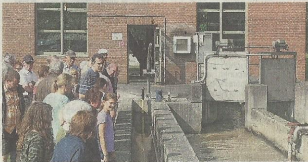
Die Teilnehmer begutachten das ausströmende Wasser nach der ersten mechanischen Reinigung in der Rechenanlage.
